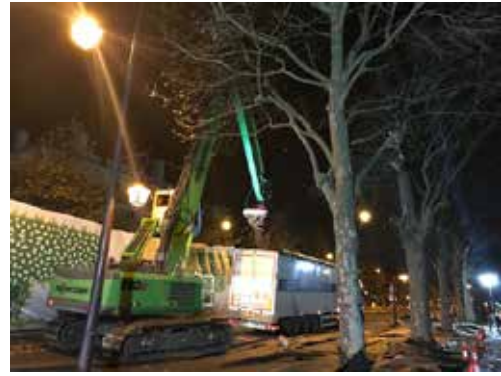
Chantier d'abattage (photo DRIAAF-SRAL)
