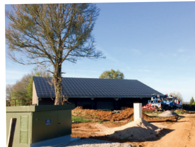
Bâtiment agricole neuf de la SAS 58 Solaire
